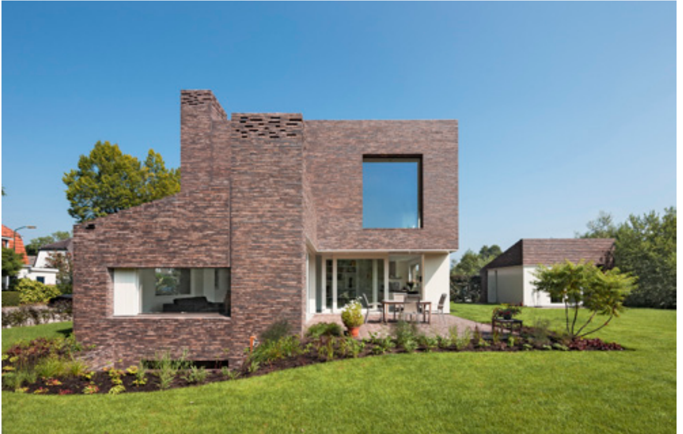
De baksteen-monoliet wordt geperforeerd door strakke raamopeningen met diepe negges. Aan de straatzijde is de gevel relatief gesloten, maar naar het landschap worden de gevelopeningen groter en opent het huis zich.
