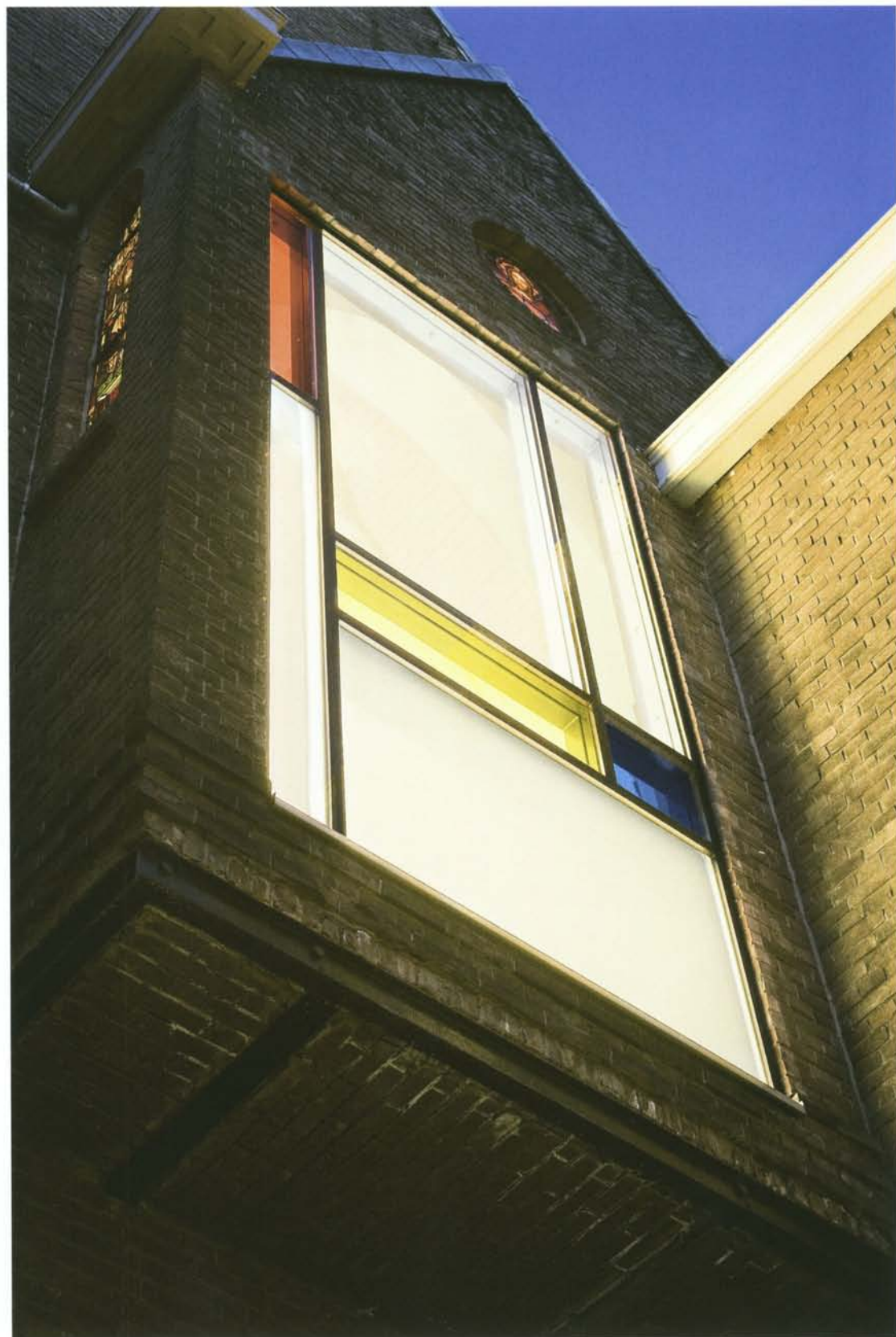
Ein farbiges Glasfenster schafft heute die Verbindung nach draußen. A coloured glass window creates a connection to the exterior.
