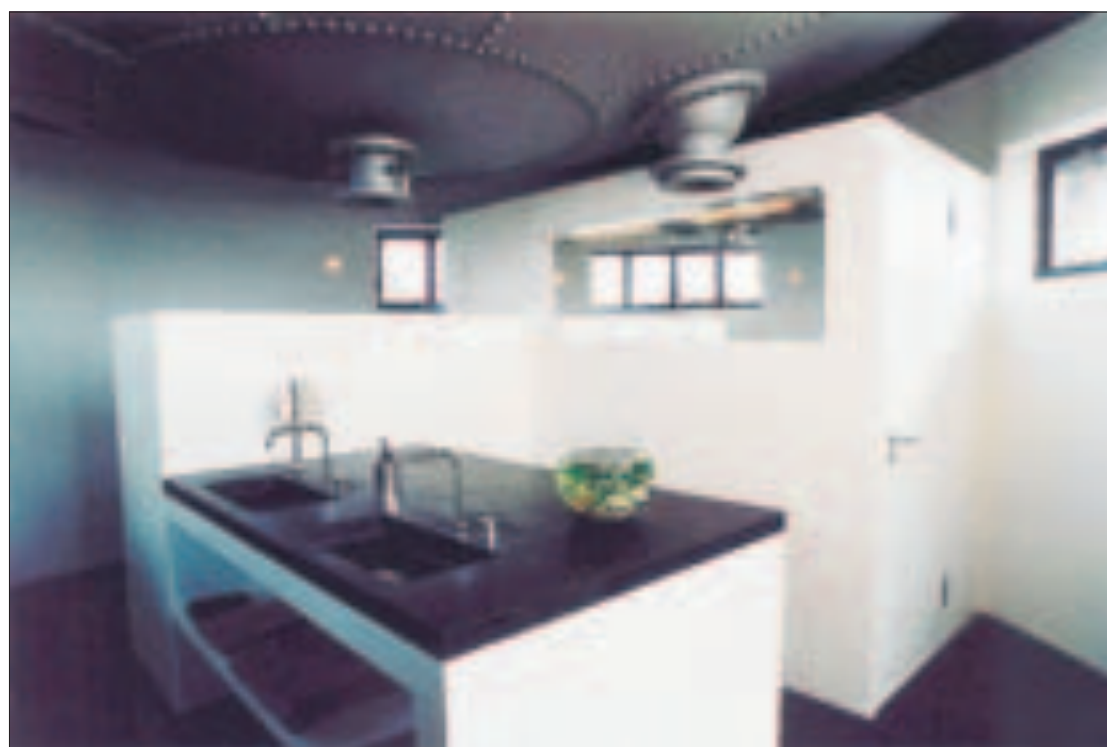
De bodem van het waterreservoir is nu plafond van de badkamer. De toren kreeg overal nieuwe, uiteenlopende trappen die toch authentiek aandoen.
