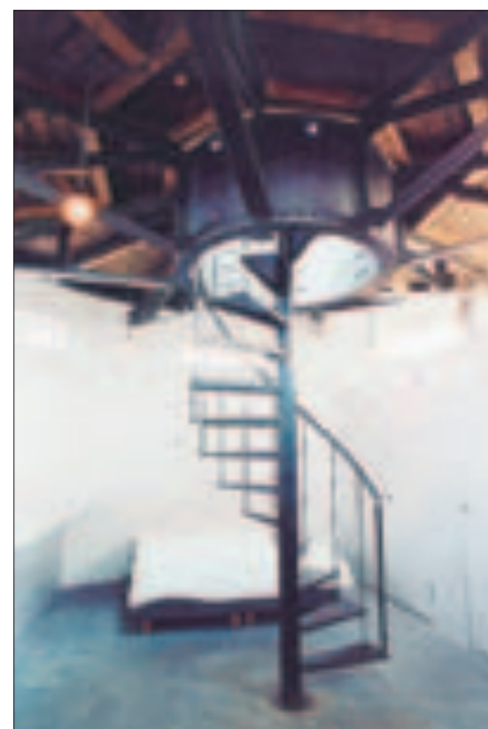
De bodem van het waterreservoir is nu plafond van de badkamer. De toren kreeg overal nieuwe, uiteenlopende trappen die toch authentiek aandoen.
