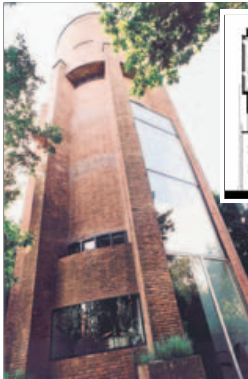
Over drie verdiepingen heeft de toren een vide gekregen, zodat er meer daglicht naar binnen komt. De nieuwe indeling van de toren.
