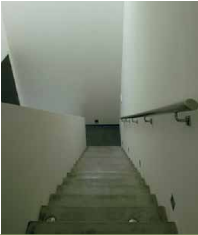
Trappenhuis: de hijsgaten in de betonnen treden zijn opgevuld met rvs schijven.
