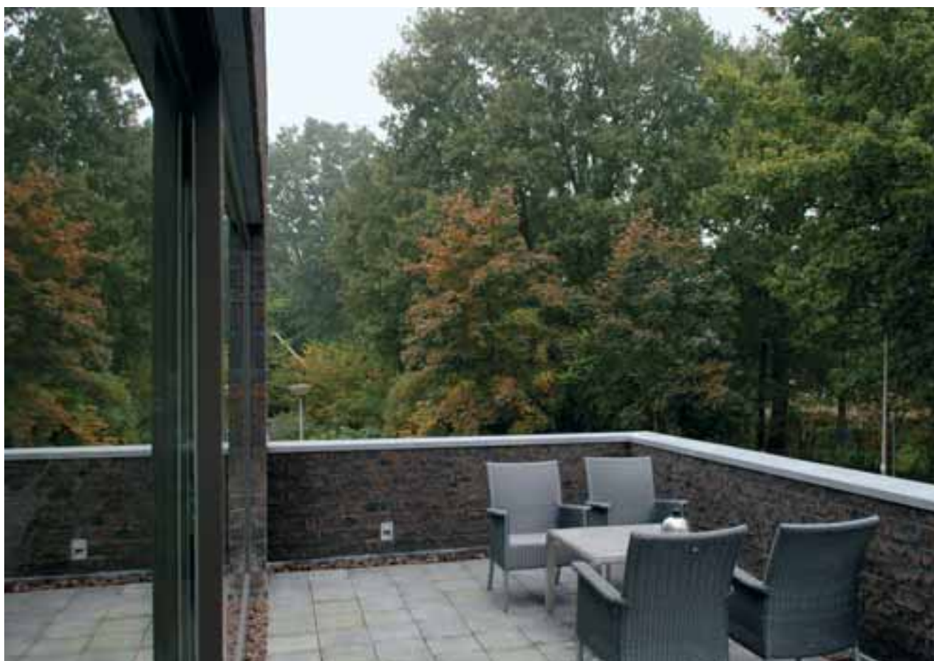
Dakterras, balkonrand afgewerkt met zinkwerk.
