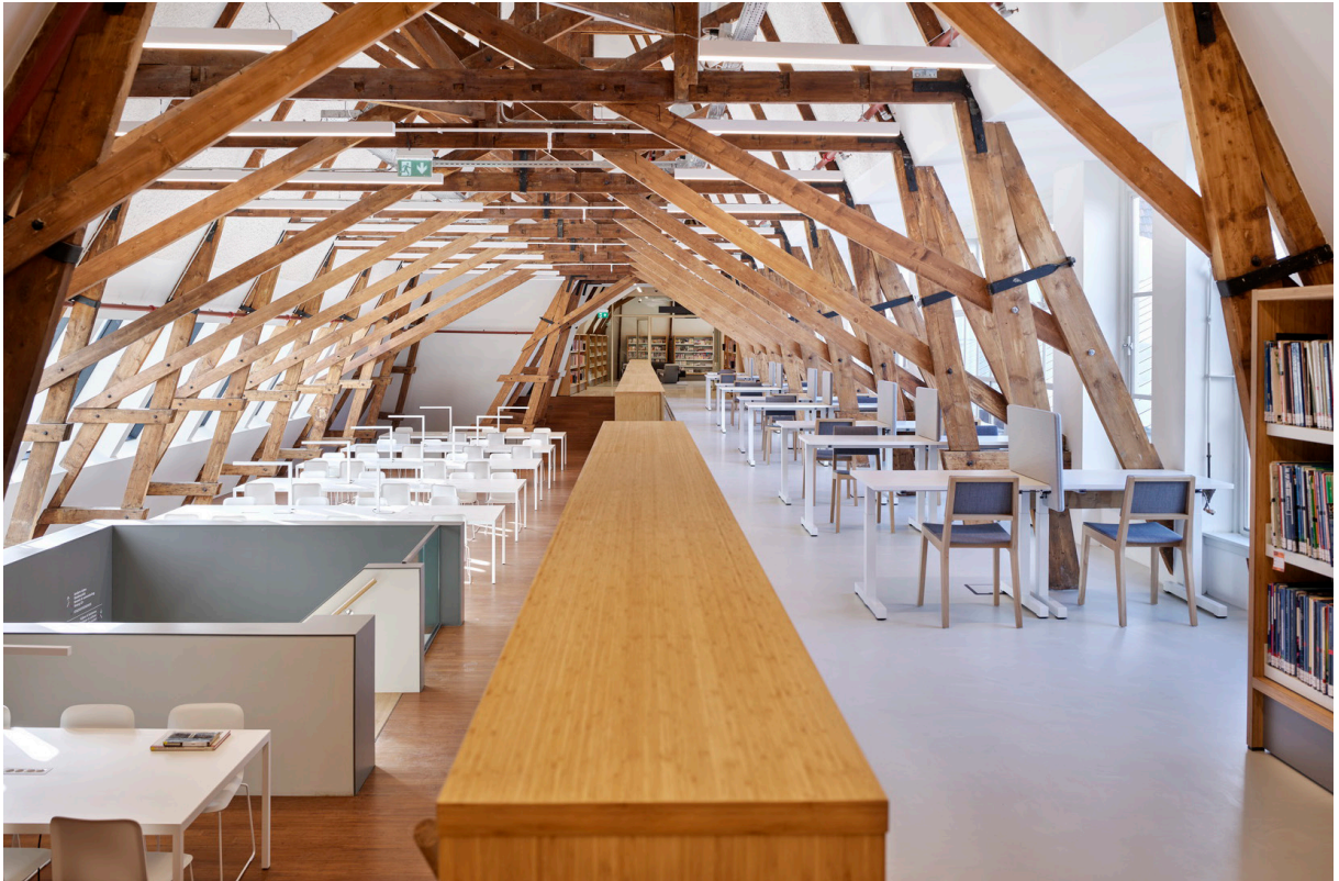
Het Stadsstudehuis met nieuwe dakramen, door de verschillende vloerniveaus' onstaat er zicht naar De Neude
